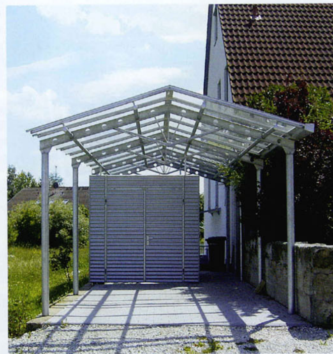
Zur Gestaltung von Zweckbauten wie Carports ist Edelstahl gut geeignet. Da er leicht formbar ist und zahlreiche Verarbeitungsmöglichkeiten zulässt, können Bauwerke aus diesem Material sehr elegant sein. Foto: Stahl-Metallbau Schmidt
