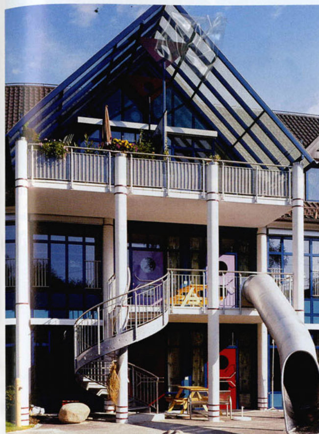
Außenbauteile aus Edelstahl sind beim Hausbau sehr gefragt, da dieses Metall äußerst langlebig und nahezu verschleißfrei ist. Sogar ohne regelmäßige Pflege bewahrt es Wind und Wetter zum Trotz seinen strahlenden Glanz. Foto: Nirosta
